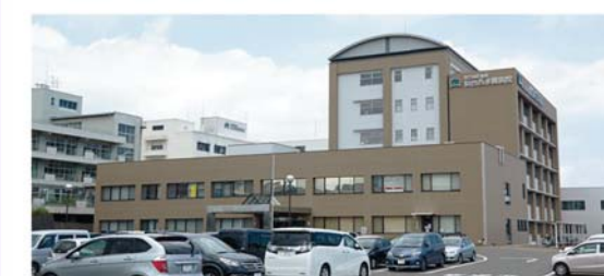
仙台西多賀病院(宮城県仙台市) 許可病床数 480床
